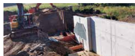
20/09/2022: Pose de la grille et de la guillotine
