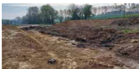
19/04/2022: Montée de la digue
