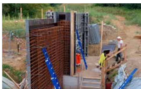
17/08/2022: pose de l'armature verticale
