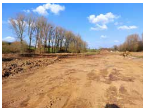
22/03/2022: Début des travaux
