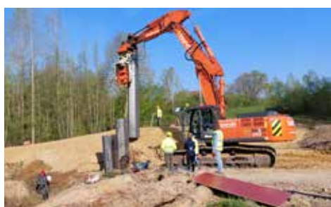
22/04/2022: Pose des premières palplanches
