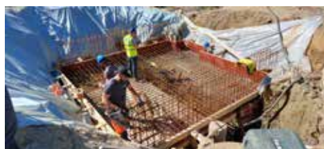
14/06/2022: Ferrailage avant la coulée du béton
