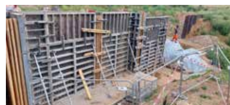
17/08/2022: Pose des voiles
