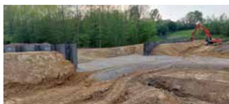
03/05/2022: Les palplanches sont en place
