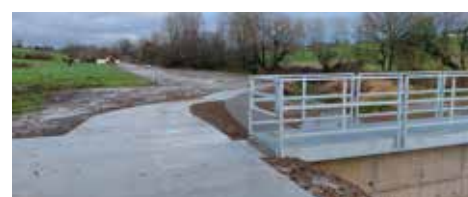
11/10/2022: Pose de la passerelle et finalisation
