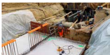
21/06/2022: Le béton est coulé
