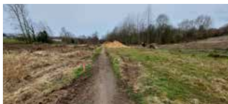
15/03/2022: Démarrage des travaux - repérage
