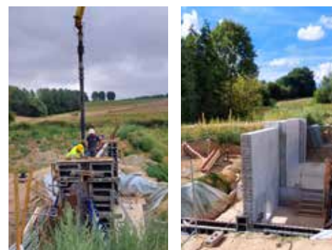
17 et 23/08/2022: Coulée du béton
